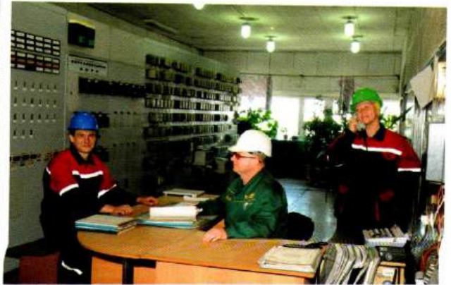
Начальник смены Манойлов О.В., машинист топливоподачи Петрова О., слесарь Асколков Д.
