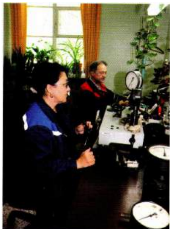
Электрослесарь по ремонту КИПиА Янгучина Р.М., Ширкунов А.В.
