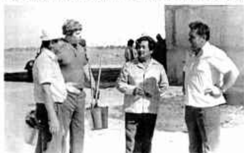
На стройке первого 9-этажного дома. Зав. стр. отделом горкома партии Ержанов А. и инж. Крылов, Райский.
