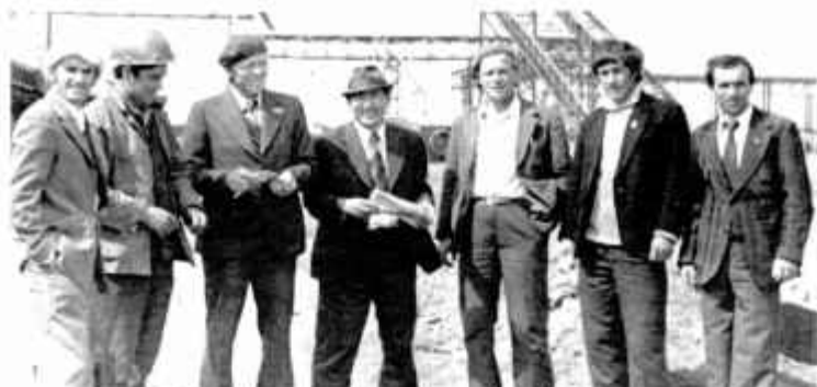
Работники газеты «Заветы Ильича» Оноприенко П., Голянский на площадке стр-ва ГРЭС-1
