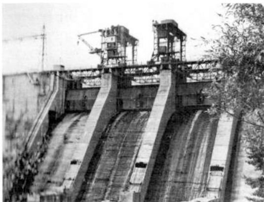
Плотина Усть-Каменогорской ГЭС
