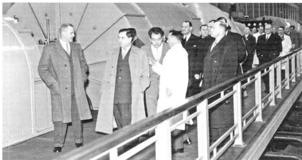
В турбинном отделении электростанции «Хэмп Холл»
