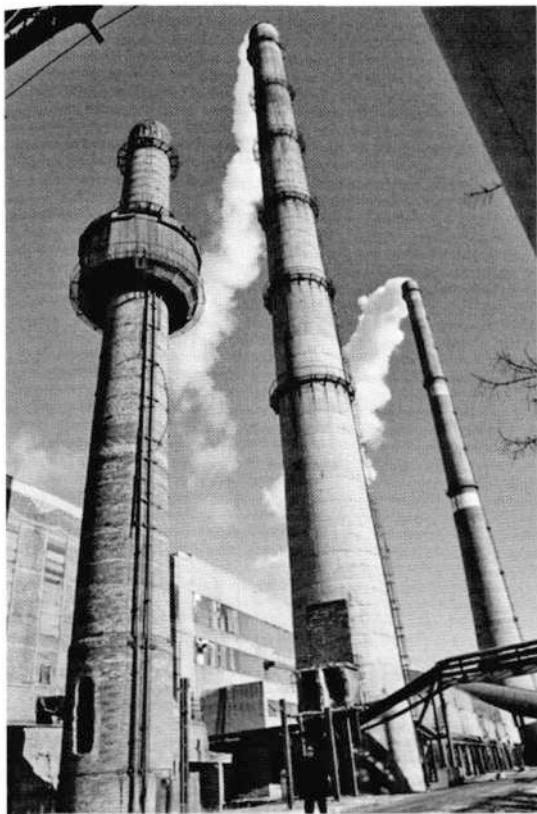
«Маленковская» труба на ТЭЦ
