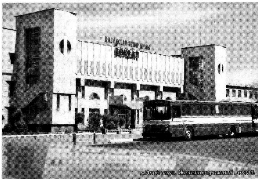
Железнодорожный вокзал г. Экибастуза, введен в 1987 г.
