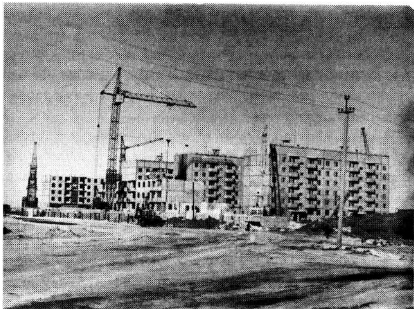
Строительство посёлка «Солнечный»
