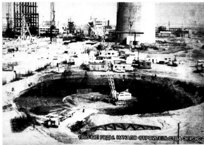
Фрагмент строительства экибастузской ГРЭС-2
