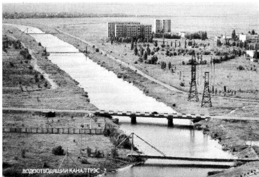
Водоотводящий канал ГРЭС-2. Видны дома посёлка «Солнечный»
