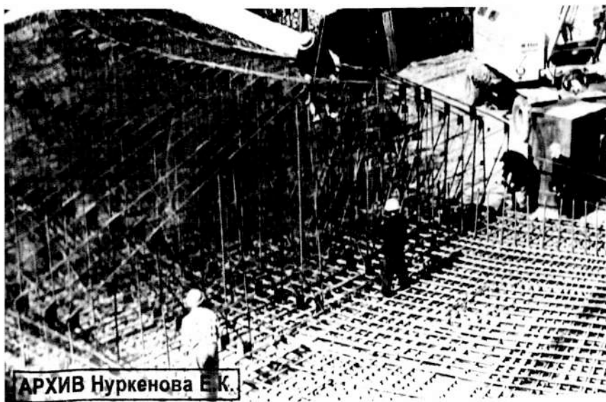
Монтаж фундаментов трубы
