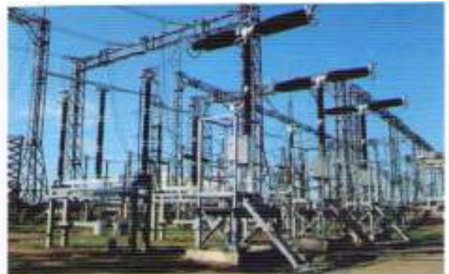
На Экибастузской ГРЭС-1 проведена модернизация ОРУ-500 кВ.
