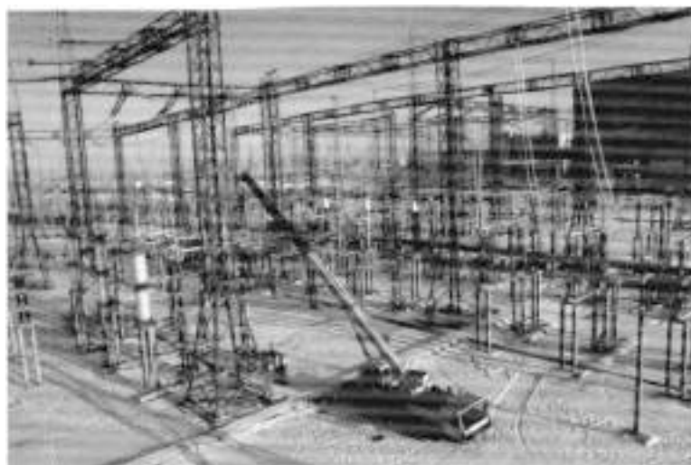
На экибастузской ГРЭС-2 проведена модернизация ОРУ-500 кВ.
