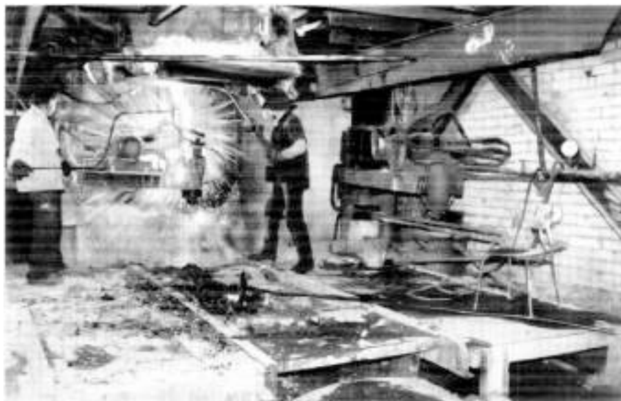
Уникальная технология производства ферросиликоалюминия.
