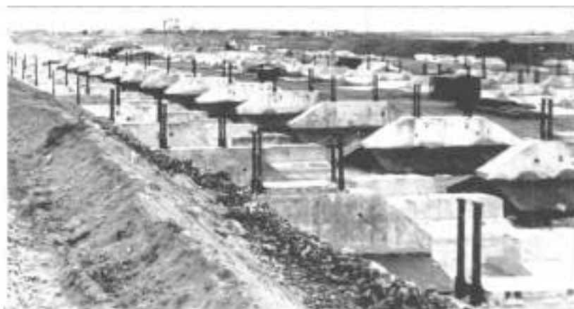
Закладка основания дымовой трубы ГРЭС-1
