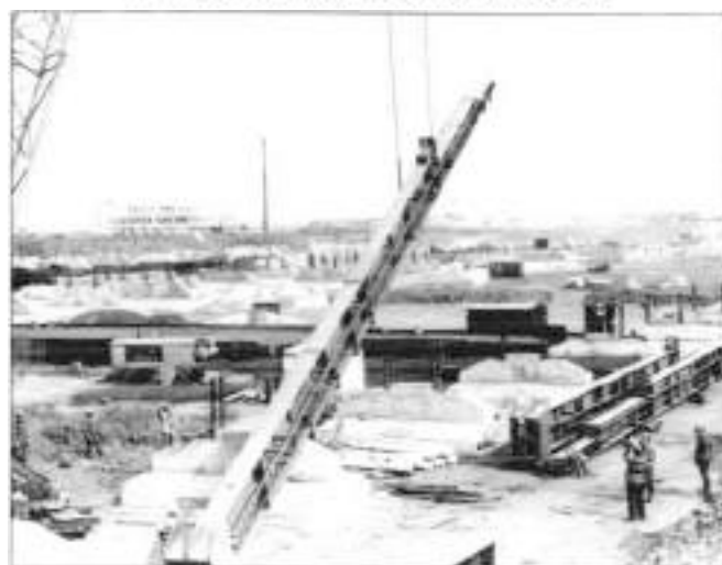
Монтаж первых колонн станции.
