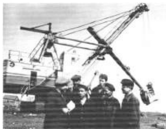
Закончен монтаж экскаватора ЭКГ-4И 1966 г.
