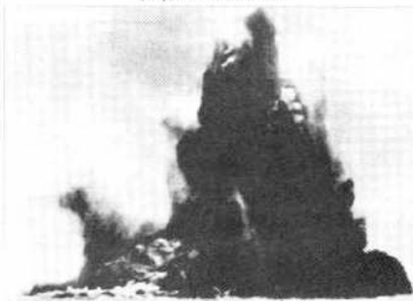
Первый взрыв на строительстве углеразреза № 1 (1948 г.)
