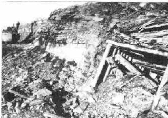
Старые шахтные выработки, вскрытые горными работами на разрезе «Северный», 1958 г.
