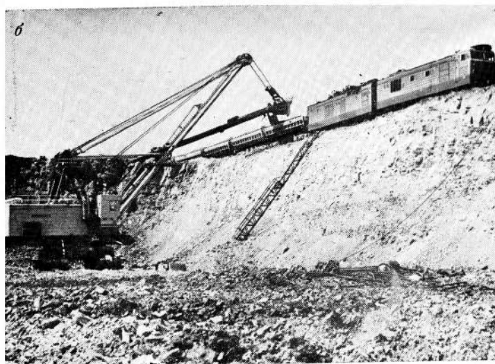
Рис. 4.4. Погрузка вскрышных пород экскаваторами ЭКГ-12,5 (а) и ЭКГ-6,3У (б)
